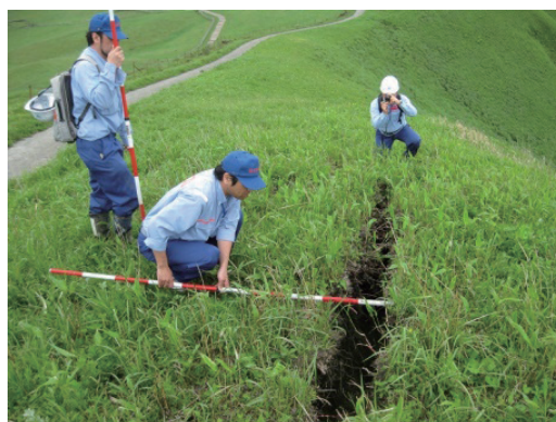
写真1 地震により生じた亀裂の調査
