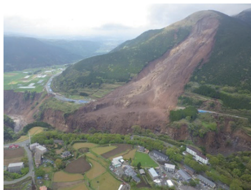
写真2 阿蘇大橋付近の大規模な斜面崩壊
