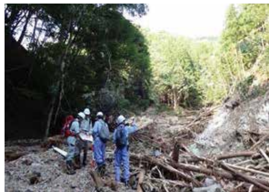
写真 土砂災害研究部による溪流の土砂流出状況調査(日光市芹沢地区)
