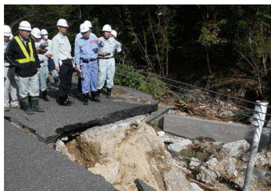
写真 崩落した道路の復旧にあたっての技術的助言を行う数雅行道路基盤研究室長(日光市)
