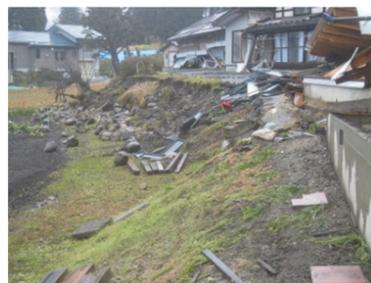
写真 崩壊した石垣
