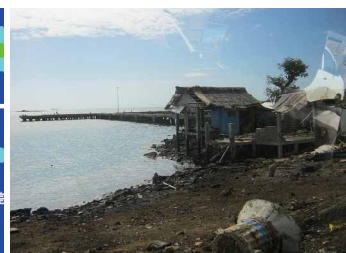
写真 エスタンシア港の被災状況
