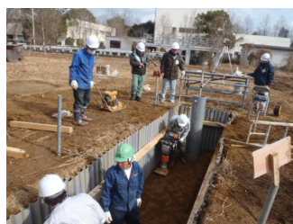
塩ビ管の施工状況
