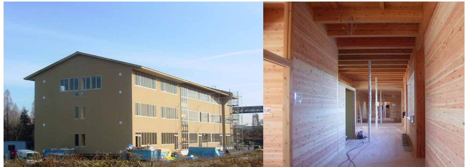
写真 実験建物の全景と内部の様子
