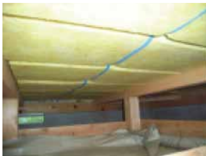
省エネルギー改修の手法の例 (左から、「床下気流止め工法」「床下充填断熱工法」「アタッチメント工法」)
