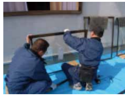
省エネルギー改修の手法の例 (左から、「床下気流止め工法」「床下充填断熱工法」「アタッチメント工法」)
