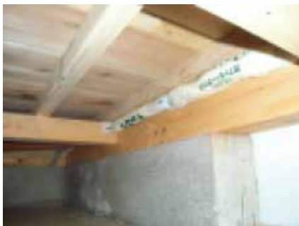
省エネルギー改修の手法の例 (左から、「床下気流止め工法」「床下充填断熱工法」「アタッチメント工法」)
