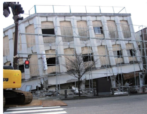
地震動(左)と津波(右)による建築物被害の事例
