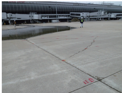
エプロンに発生したクラックと水たまり
