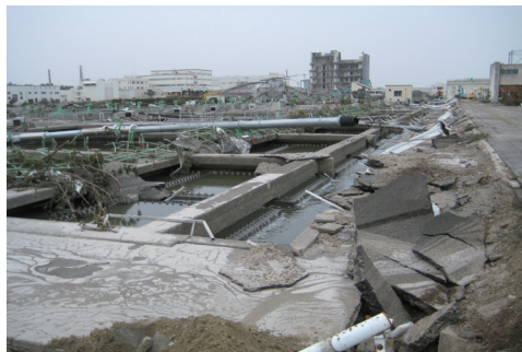
南蒲生浄化センター(仙台市)の被災状況
