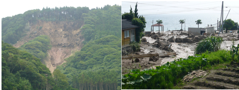
写真-1 船石川崩壊地
