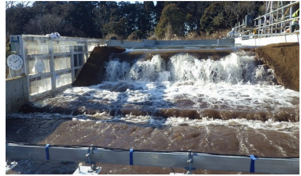
図-3 越水時の白波の発生状況
