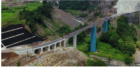
写真-1 阿蘇長陽大橋（復旧工事中）
