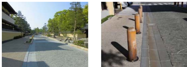
図-3 使い勝手に配慮した横断構成：セミフラット形式の歩道（左）と着脱式のポラード（右）【福岡市承天寺通り】（※市提供）
