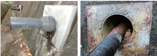
図2 アンカー頭部の状況 (左：防錆油の流出、右：頭部背面の空洞)
