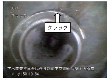
写真 2 下水道管の劣化状態②
