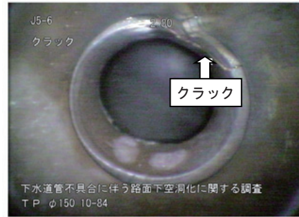
写真 1 下水道管の劣化状態①
