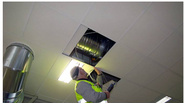
写真2 スウェーデンにおける換気空調設備の現場における性能検証（k-factor法による測定）
