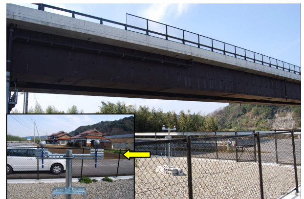
写真-2 鋼球曝露試験
