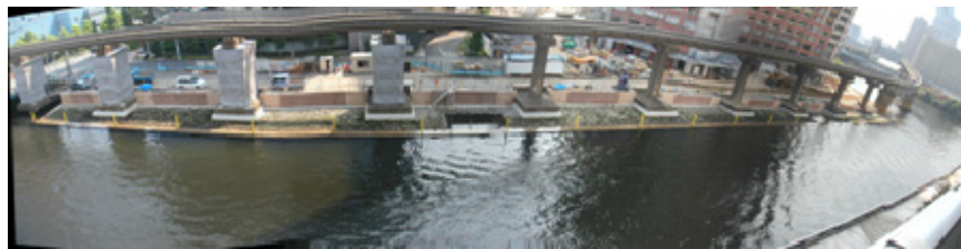
図-3 テラス型護岸に設けた潮だまりの現況写真(全景)
