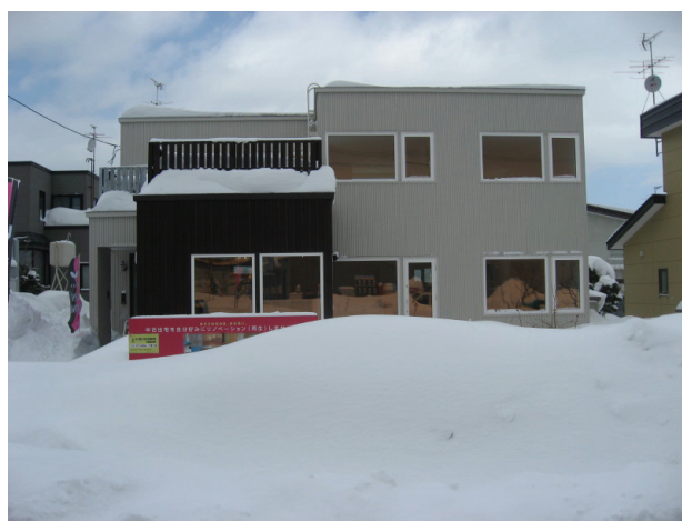
※築後35年の既存住宅を高断熱の新築同様に改修
