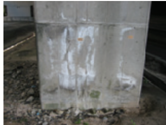
写真-1 柱部地表面付近の状況
