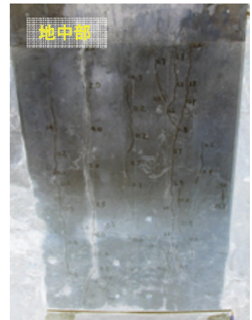
写真-4 柱部のひび割れ状況
