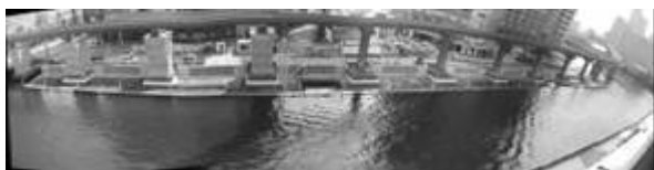
図-2 芝浦アイランドにおけるテラス型護岸に設けた潮だまりの現況写真(全景)
