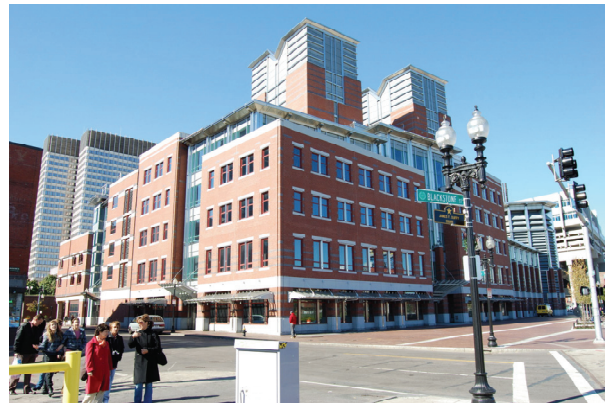
写真-1 ポストンビッグディグ事業の換気塔（駐車施設・店舗・地下鉄駅との複合開発）
