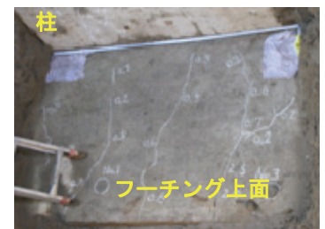
写真-5 フーチング上面のひび割れ状況
