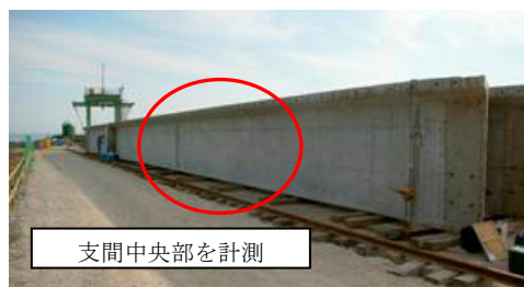
写真-2 対象橋梁
