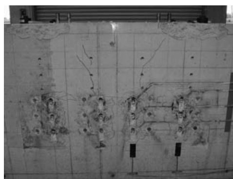
写真-4 実構造供試体の破壊状況
