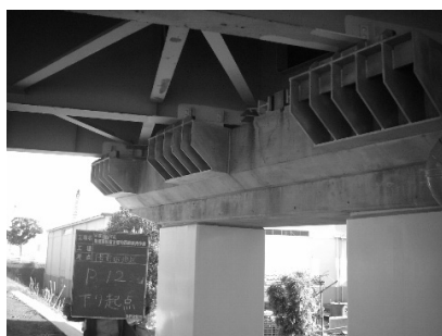
写真-1 落橋防止構造
