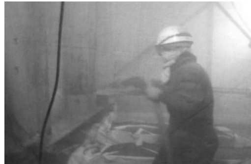
図-3 ブラストによる素地調整状況
