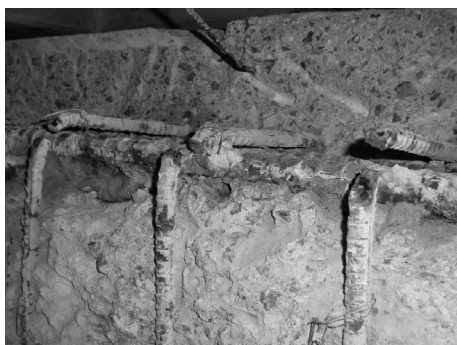
写真-1 ASRによる鉄筋破断の例
