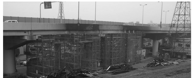
写真 2 火災により損傷を受けた橋梁
