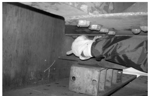
図-5 狭隘部の塗装状況
