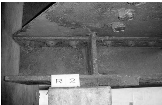
図-2 機械工具による施工後(ガセット裏)
