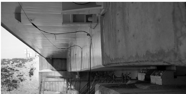
写真 1 ひび割れが発生し死荷重状態でたわみが生じている橋梁
