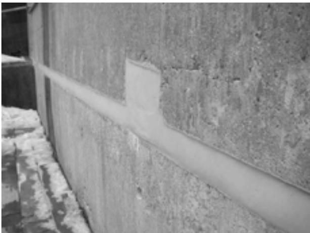
写真-4 目地充填完了
