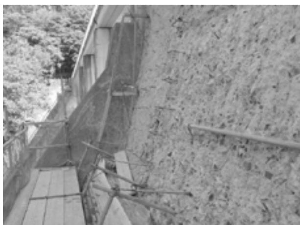
写真-1 堤体表面コンクリート打ち替え状況
