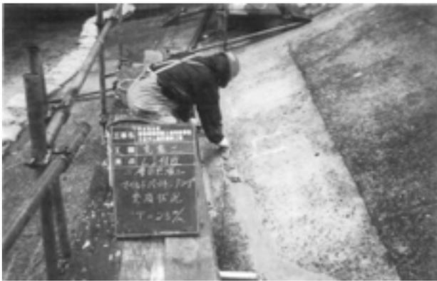
写真-2 堤趾部ひび割れ補修工事
