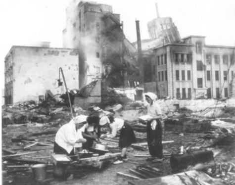
【写真 2】倒壊した大和百貨店
