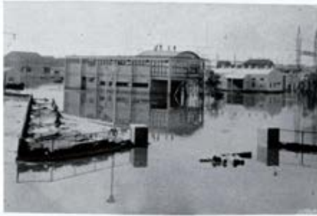
【写真 1】 東北電力八戸変電所付近
