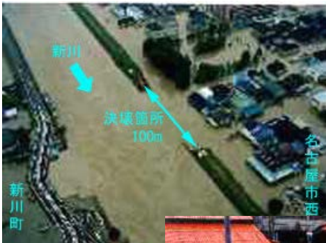
【写真 1】 新川の破堤箇所（上空より）
