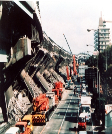
【写真 1】高速道路の崩壊
