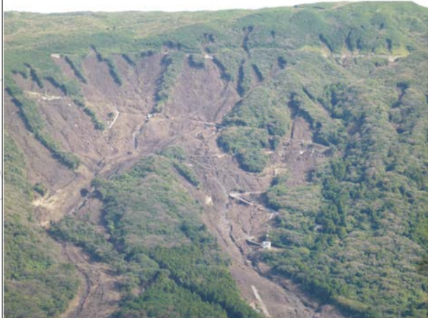
【写真1】伊豆大島の土石流現場
