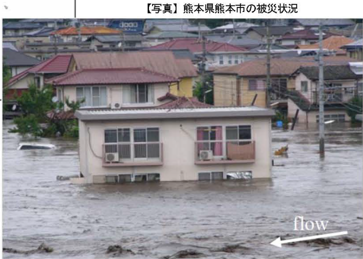
【写真】熊本県熊本市の被災状況
