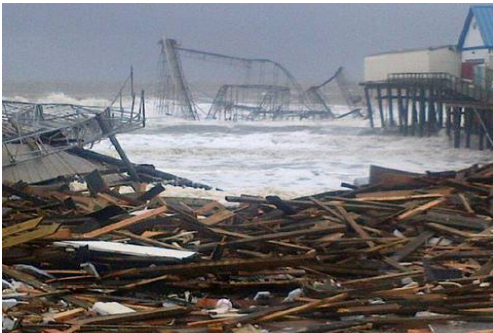
【写真 1】沿岸地域での被災状況
