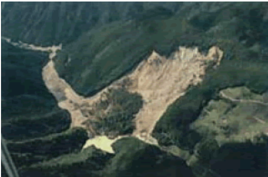
【写真 1】紀伊半島の土砂災害現場
