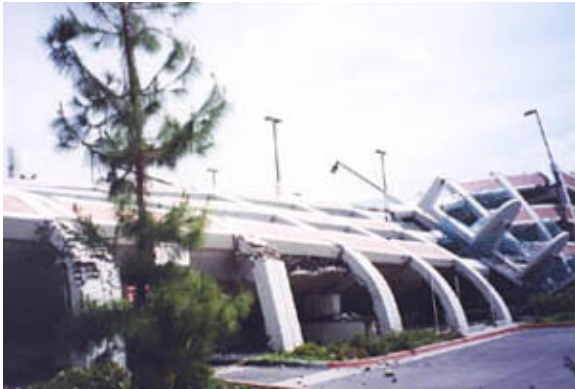
【写真 1】崩壊した商業施設
