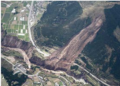
【写真 2】阿蘇大橋地区の斜面崩壊
