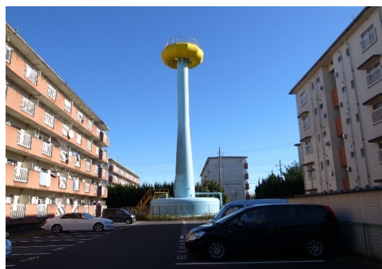
写真Ⅱ.3.13 団地内の給水塔
