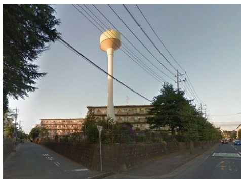
写真Ⅱ.3.7 団地内の給水塔
