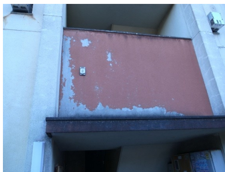
写真Ⅱ.3.17 階段室の状況
