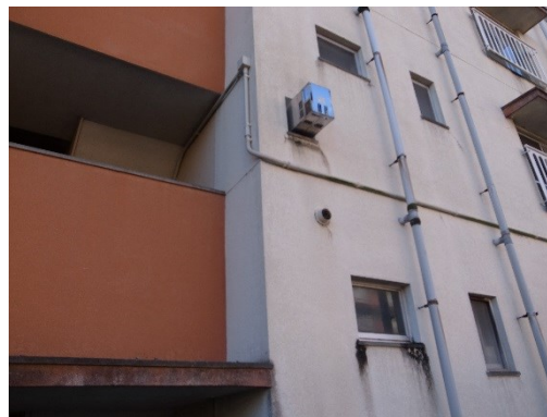
写真Ⅱ.3.19 階段室の状況
