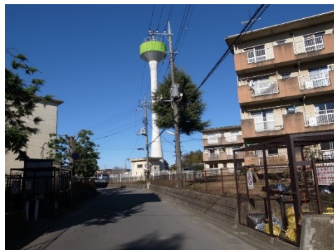
写真Ⅱ.3.8 団地内の給水塔
