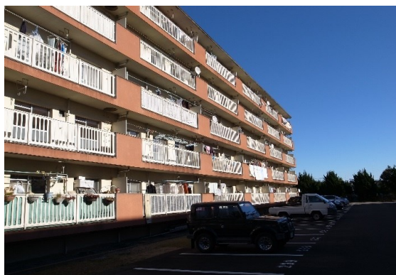
写真Ⅱ.3.12 中層耐火 5 階建て住棟
