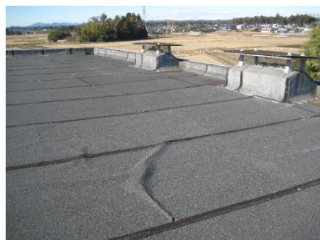
写真Ⅱ.3.3 露出アスファルト防水の状況
