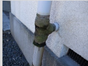
応急処置がなされた雑排水管
