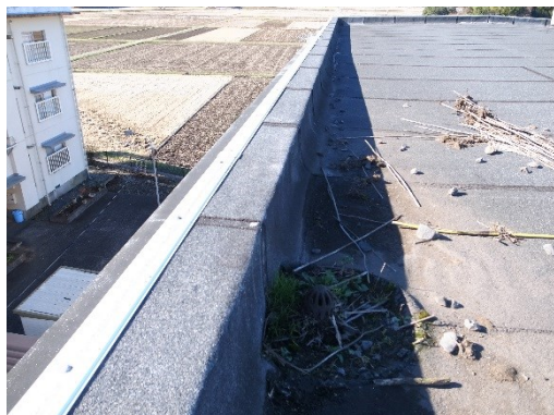
写真Ⅱ.3.14 露出アスファルト防水の状況 写真Ⅱ.3.15 露出アスファルト防水の状況
