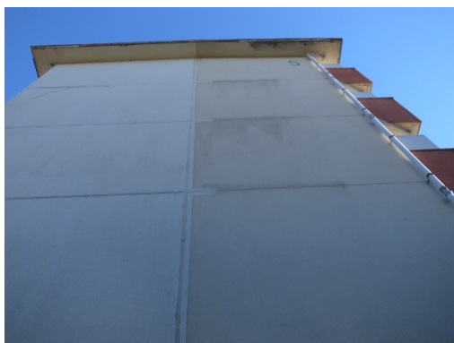
写真Ⅱ.3.18 外壁妻側の状況
