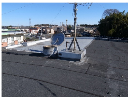
写真Ⅱ.3.14 露出アスファルト防水の状況 写真Ⅱ.3.15 露出アスファルト防水の状況
