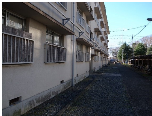
写真Ⅱ.3.5 北側外壁の状況
