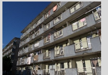
対象住棟の現況写真
