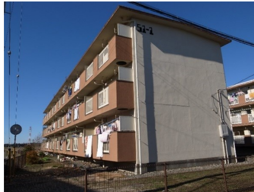
写真Ⅱ.3.6 外壁妻側の状況
