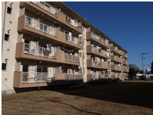
写真Ⅱ.3.4 南側外壁の状況
