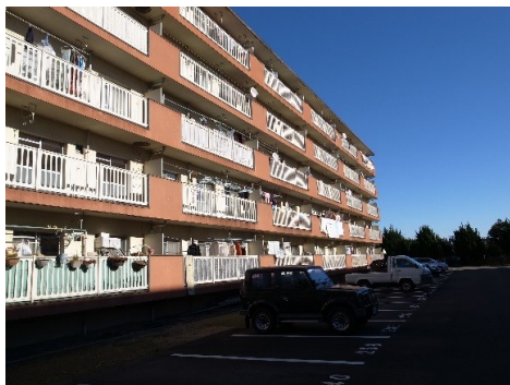
写真Ⅱ.3.16 南側外壁の状況
