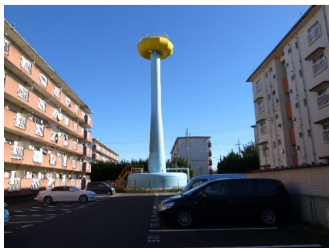
写真Ⅱ.3.20 団地内の給水塔
