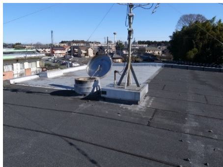
写真Ⅱ.3.2 露出アスファルト防水の状況
