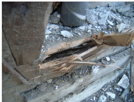
図 劣化状況の例（段階別）
