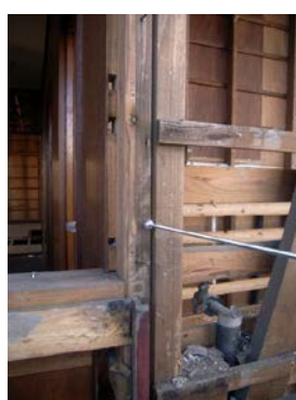
図 打診の状況の例
