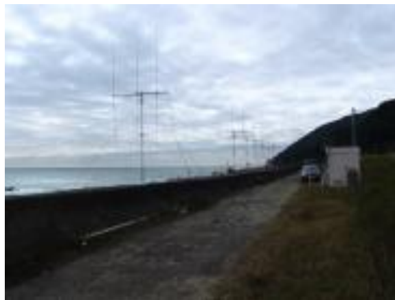
写真-2.1 美浜局の設置状況
