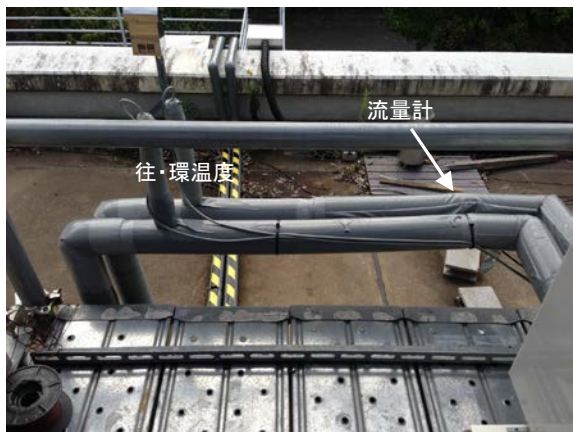
写真3. 9 地中システムの計測
