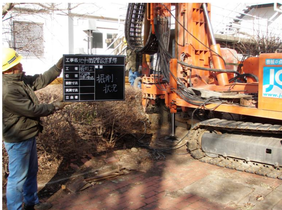
写真 3. 1 地盤の掘削状況
