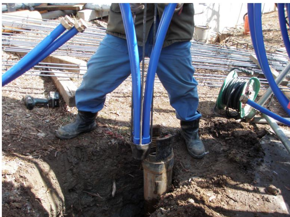
写真3. 2 Uチューブの設置作業
