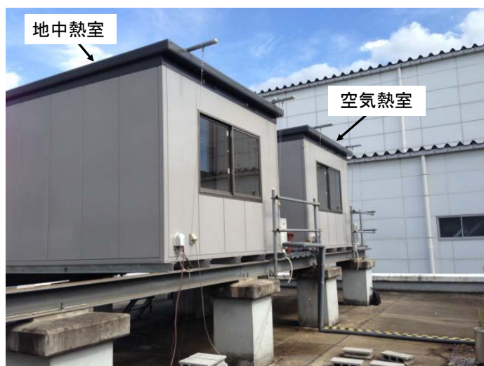
写真3. 4 ユニットハウス2棟の設置状況
