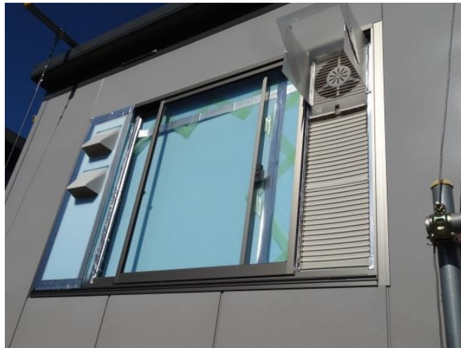
写真 4 - 4 実験施設（窓面（外側-南面））
