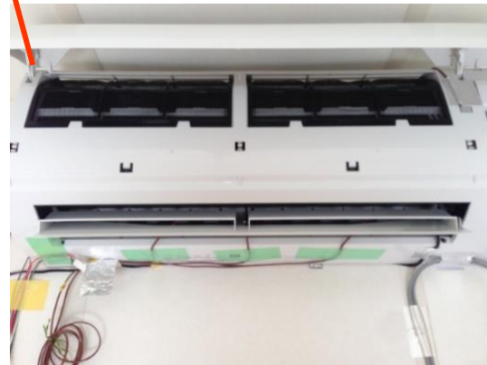
(室内機には熱処理量を計測するためのセンサー類を設置)
