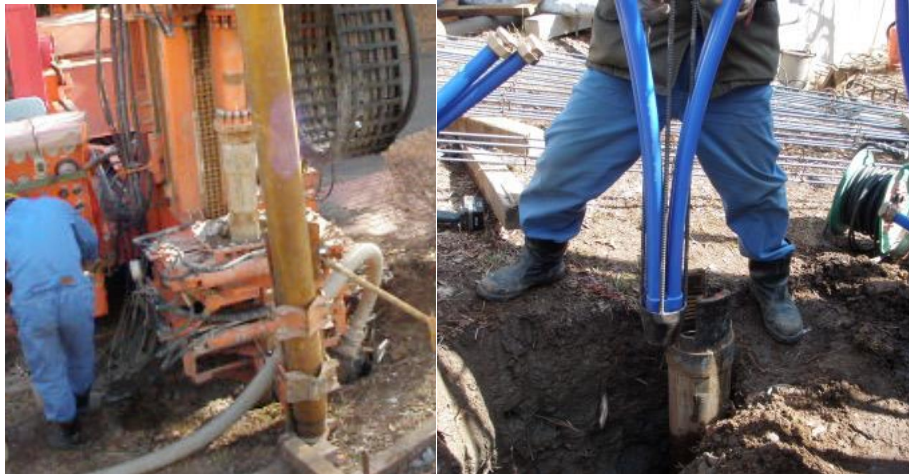
写真 4 - 3 実験施設（地中埋設管設置状況）
