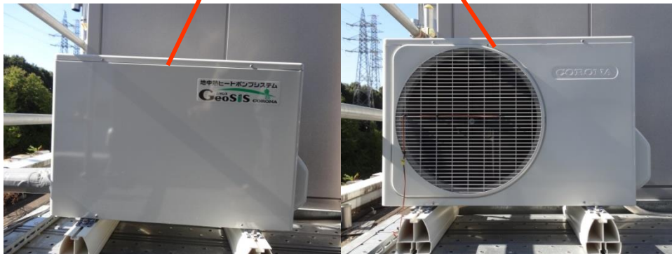
(地中熱ヒートポンプ室外機)
