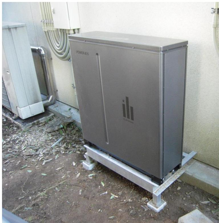
写真 5 - 4 蓄電装置の設置状況
