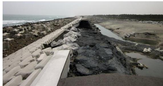
図-4.1.1 三面張り構造の海岸堤防の基本的な構造
