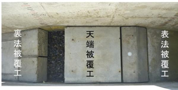
写真-4.2.4 法肩のブロックを天端被覆工と連結しないケース
