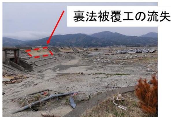
写真-4.1.4 裏法被覆工の流失（岩手県金浜海岸）
