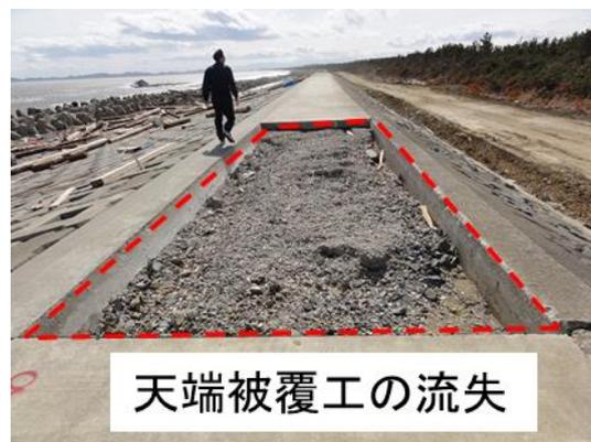
写真-4.1.5 天端被覆工の流失（宮城県大曲海岸）
