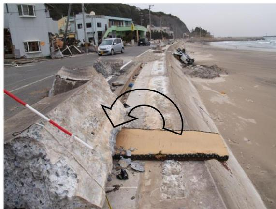
写真-4.1.6 波返工の破損（福島県豊間海岸）
