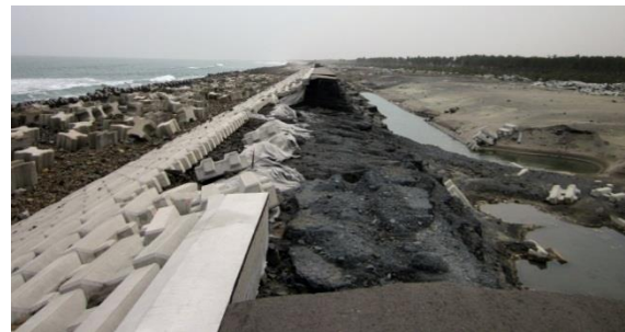
写真-4.1.1 半壊した三面張り構造の海岸堤防と裏法尻部における洗掘の状況（宮城県岩沼市蒲崎海岸）
