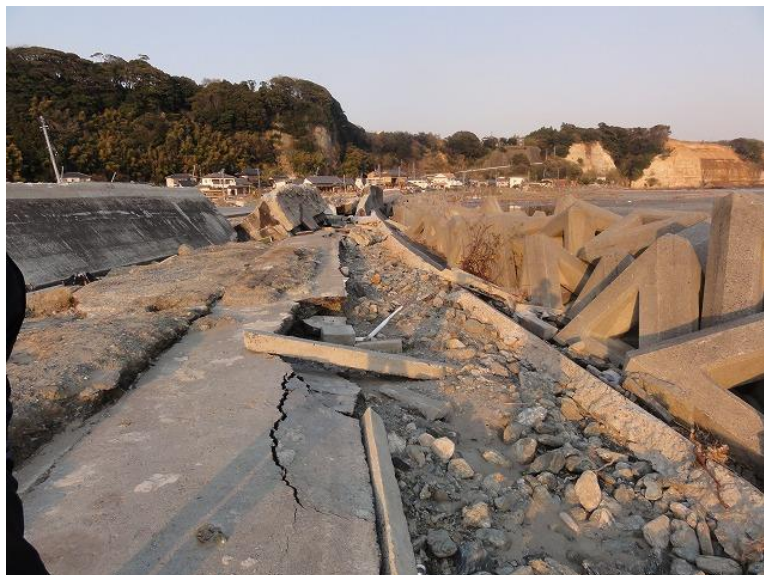
図-2.3.10 植田岩間地区海岸での波返工の破損状況
