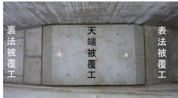
写真-4.2.5 法肩ブロックを天端被覆工と一体化したケース
