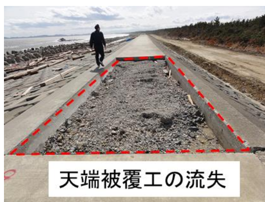
写真-4.1.5 天端被覆工の流失（宮城県大曲海岸）
