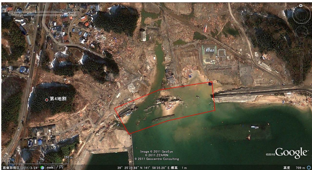
図-2.2.4 岩手県船越南海岸津波後空中写真
