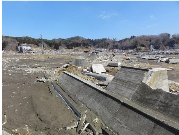
図-2.3.2 田老海岸の一線堤の被災状況
