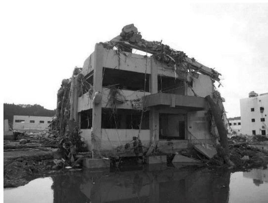
図-2.5.2 部分的な崩落
