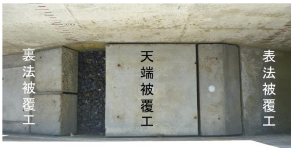
写真-4.2.4 法肩のブロックを天端被覆工と連結しないケース
