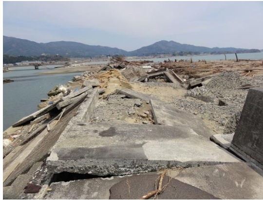
図-2.3.4 高田海岸の堤防の被災
