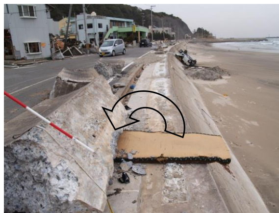
写真-4.1.6 波返工の破損（福島県豊間海岸）
