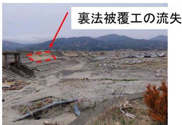
写真-4.1.4 裏法被覆工の流失（岩手県金浜海岸）
