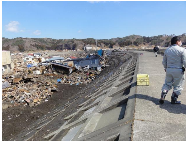
図-2.3.3 田老海岸の二線堤の状況
