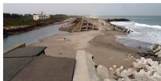
写真-4.1.9 全壊した海岸堤防
