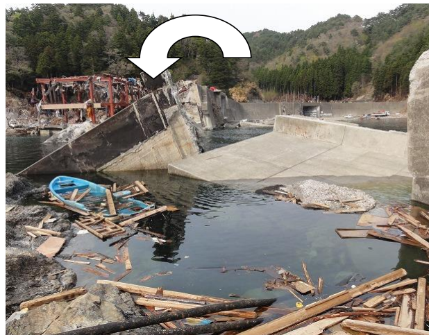
写真-4.1.8 岩手県両石漁港での重力式堤防の転倒
