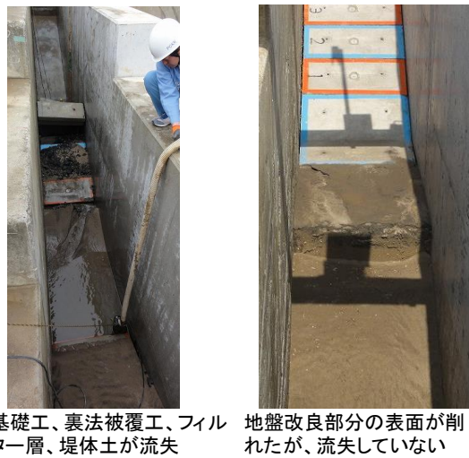
図-4.2.19 越流後の状況（越流水深 2m，左：地盤改良無し，右：地盤改良有り）
