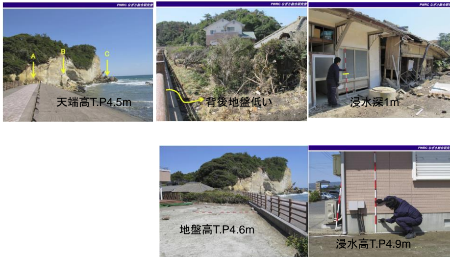
図-5.3.6 背後地地盤高による被害の違い (写真提供：(財)土木研究センターなぎさ総合研究室)
