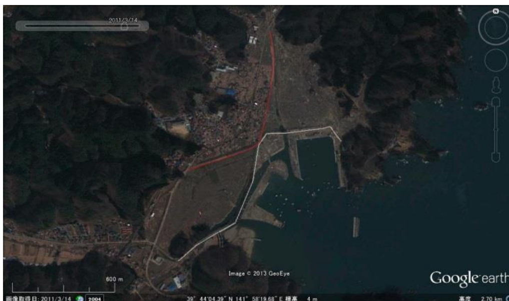
図-2.3.1 田老海岸の堤防（白線：一線堤、赤線：二線堤） [画像データ:Google, GeoEye]
