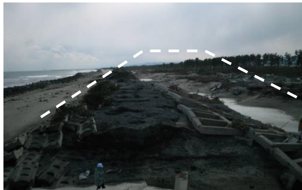
写真-4.1.3 天端・裏法が削られた海岸堤防
