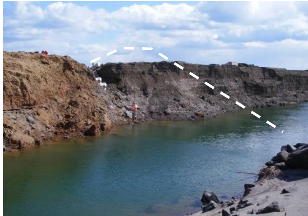
写真-4.1.2 海岸堤防陸側の深掘れ
