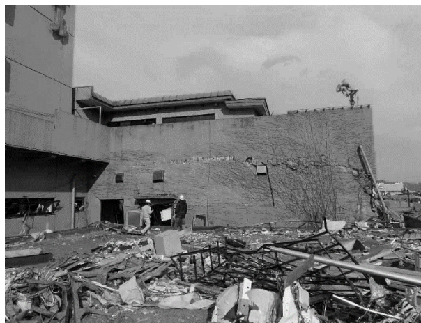
図-2.5.4 外壁の面外破壊
