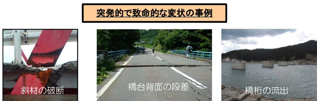
写真-7.1.1 突発的で致命的な変状の事例
