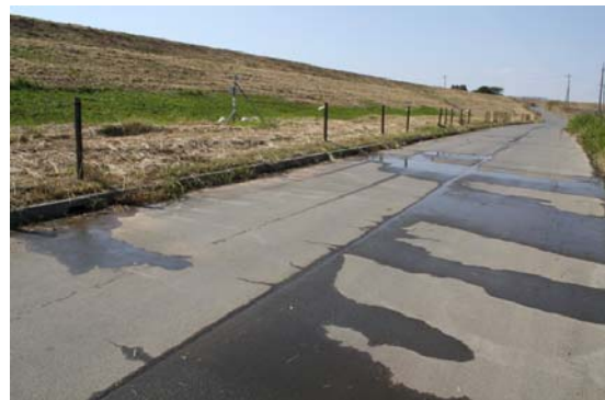
写真-6.3.2 観測対象区間の概況 (のり尻からのしぼり水)
