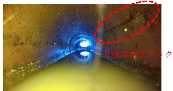
写真 4.5.6 電動 RC 制御式カメラの映像
