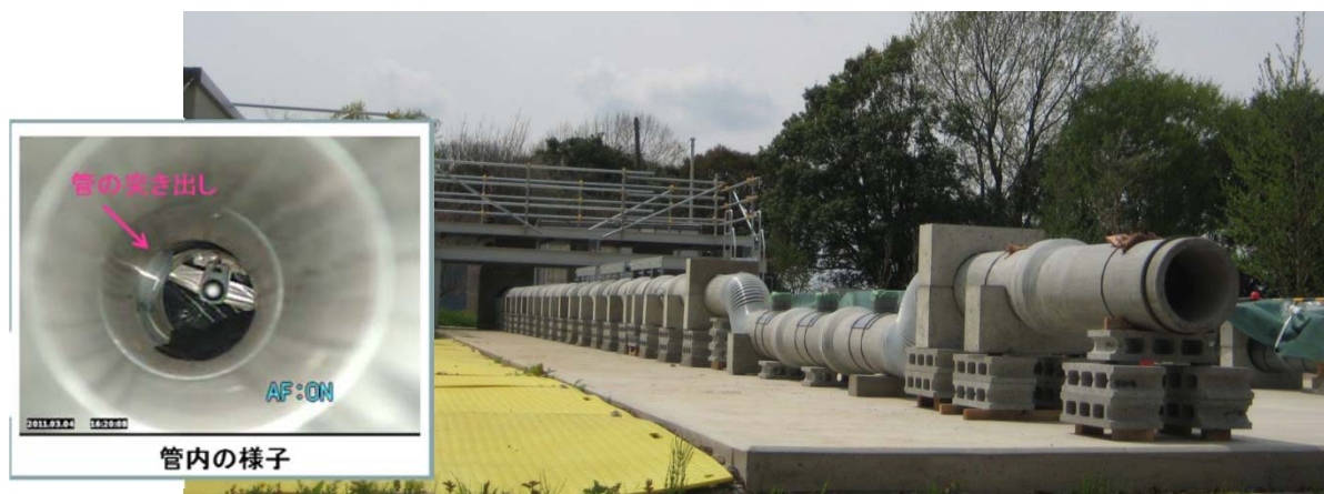
写真 - 4.3.2 模擬劣化管きょ
