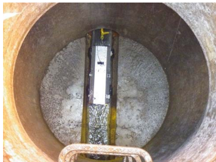
写真 4.5.5 管きょ内調査の様子
