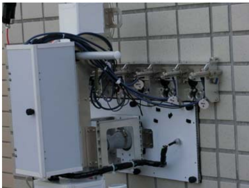
写真 3.6.4 打診装置の取付状況
