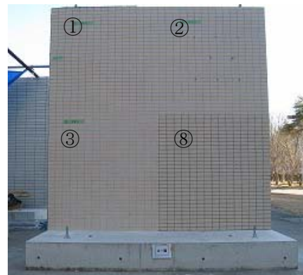
アンカーピンニング部分エポキシ樹脂注入工法 他 3 種類の補修工法
