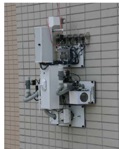
写真 3.6.2 外壁診断装置 (H24 年度)
