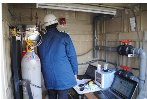
写真 2.11 パージ作業の操作状況 (ボンベ庫)
