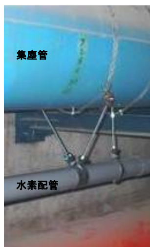
写真 2.6 架台部中間部の振れ取り
