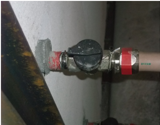
区画貫通部のずれ
