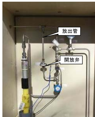
写真 2.8 外気放出管の分岐部 (開放弁を開いて分岐)
