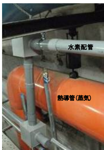
写真 2.5 特殊部曲り部の水素配管
