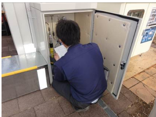
写真 2.9 開放弁の操作状況 (配管収容キャビネット)
