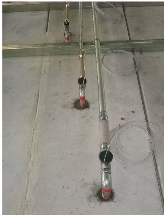
区画外でのガス栓
