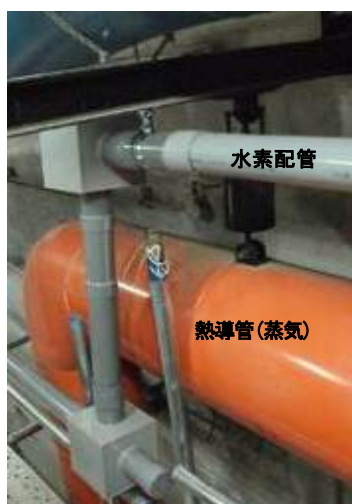
写真 2.5 特殊部曲り部の水素配管
