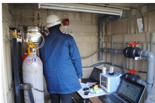
写真 2.11 パージ作業の操作状況 (ボンベ庫)
