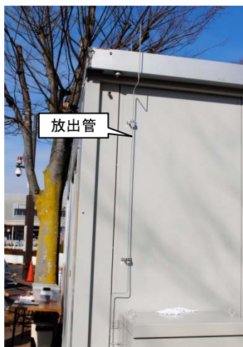
写真 2.7 外気放出管(ステンレス製)の取付け状況 (外径 : 6.35mm/肉厚 1mm、延長 : 1,800mm)
