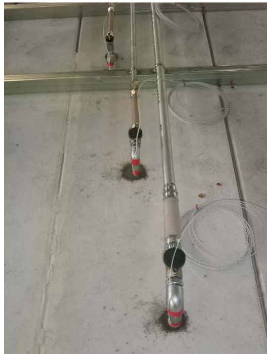
区画外でのガス栓
