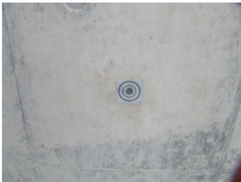
写真 3-1 監視基準点設置状況（滋賀国道）
