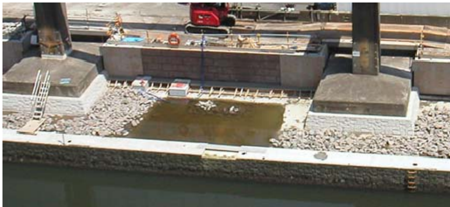
写真-4.1 東京都港区芝浦アイランド護岸を利用したテラス型干潟
