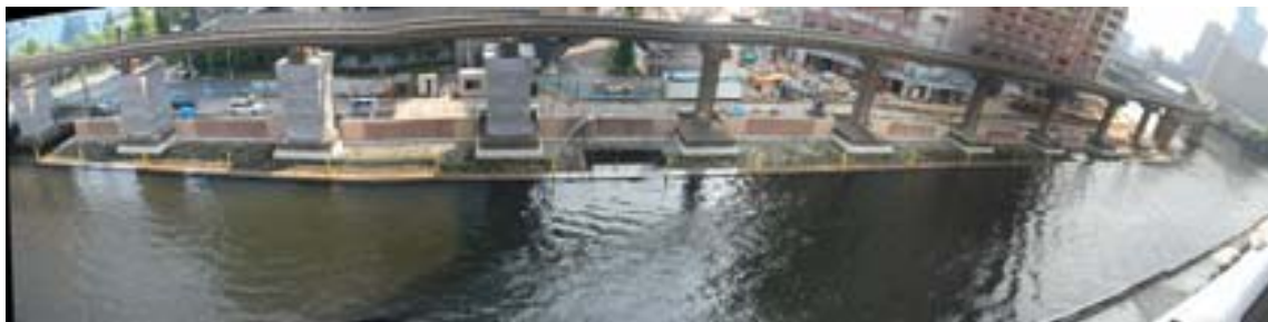
図-2.6 芝浦アイランドにおけるテラス型護岸に設けた潮だまりの現況写真(全景)
