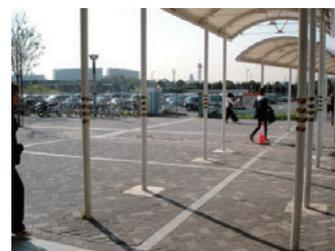
同じ素材・仕上げ・模様のパターンで仕上げることも、危険要因となる。段鼻が見えない階段、床面と同じ仕上げのボラード（車止め）、池の底と池の縁や周囲と同じ仕上げにしてある水深の非常に浅い池は、それぞれ踏み外す、はまる（踏み入れる）、ぶつかる原因になる。
