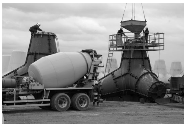
写真 3. 2-17 異形ブロック型枠(テトラポット)
