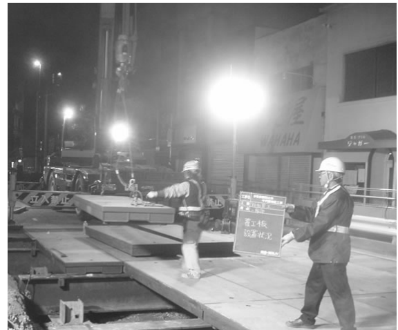
写真 3. 2-16 覆工板(設置状況)
