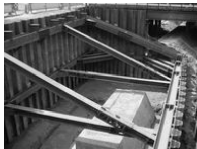
写真 3. 2-14 鋼製山留材
