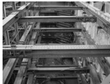
写真 3. 2-14 鋼製山留材
