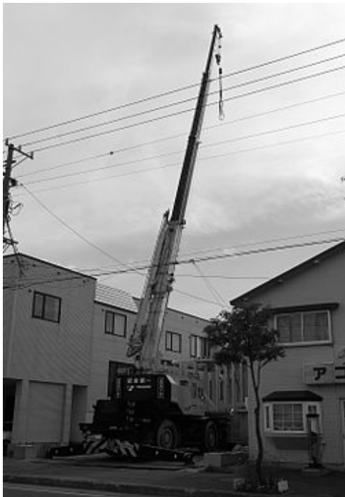
写真 3. 2-6 ラフテレーンクレーン
