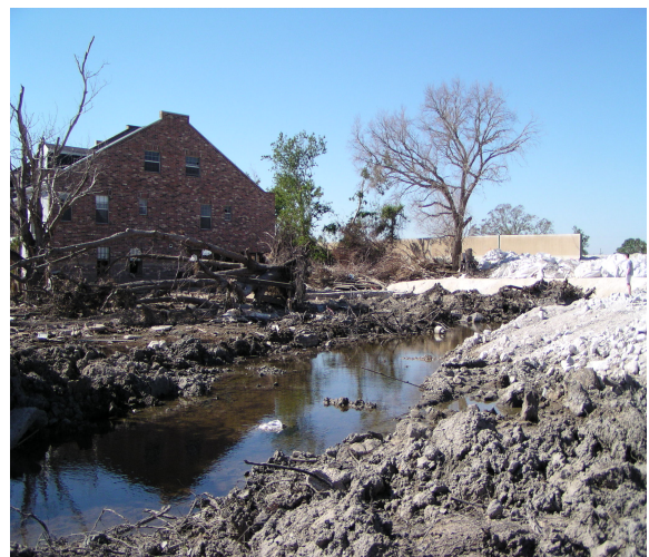
写真2-3 ニューオーリンズ市内の 破堤箇所周辺(国総研撮影)
