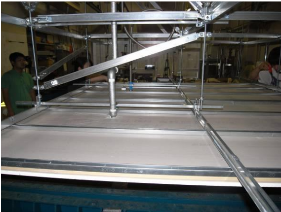
写真6 加振前の天井とスプリンクラー配管 (鋼管)
