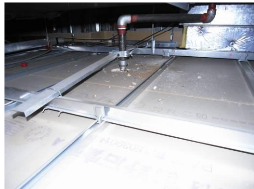
写真 3 スプリンクラーヘッドの天井内固定状況
