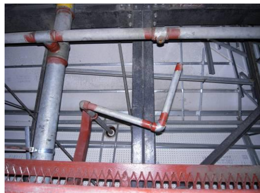
写真 4 スプリンクラー配管の地震被害例
