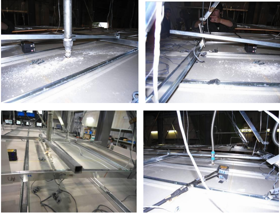
写真 13 El-centro1940 波 300%加振後
