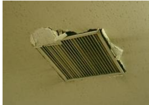
写真 1 天井制気口の地震被害例
