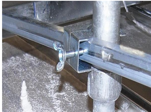
写真7 スプリンクラーヘッド固定金物のすべり (鋼管)
