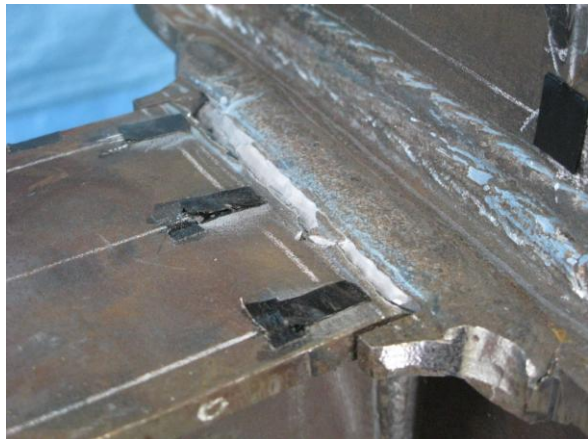
写真 5.4 梁端部破断状況 (HD-2516D)
