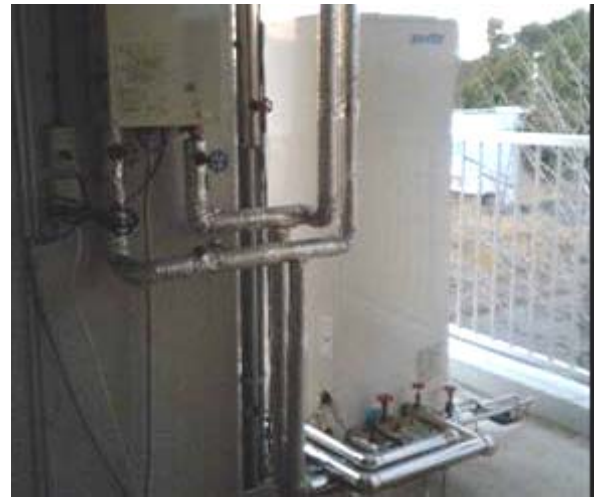
ソーラーシステム貯湯部
