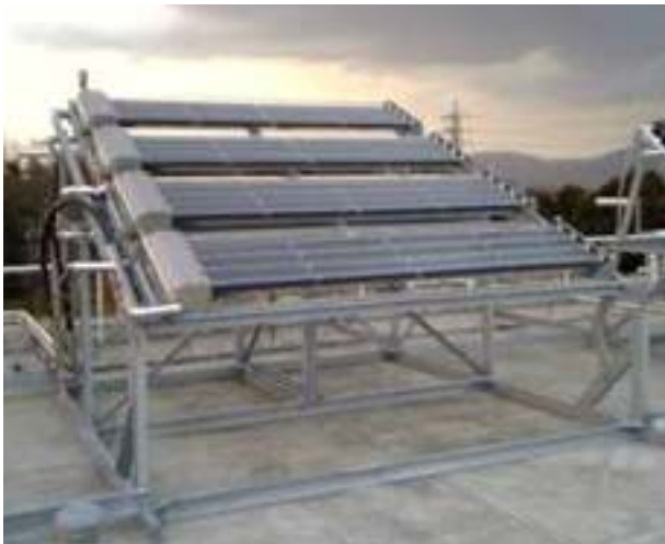
ソーラーシステム集熱部（真空管式）
