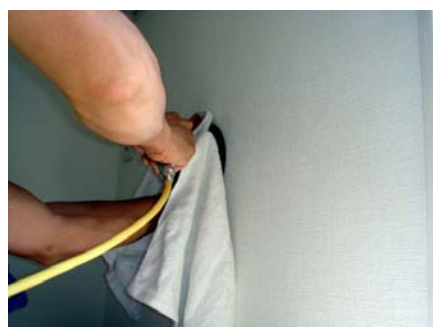
写真2.4.6 圧縮空気による掃除状況
