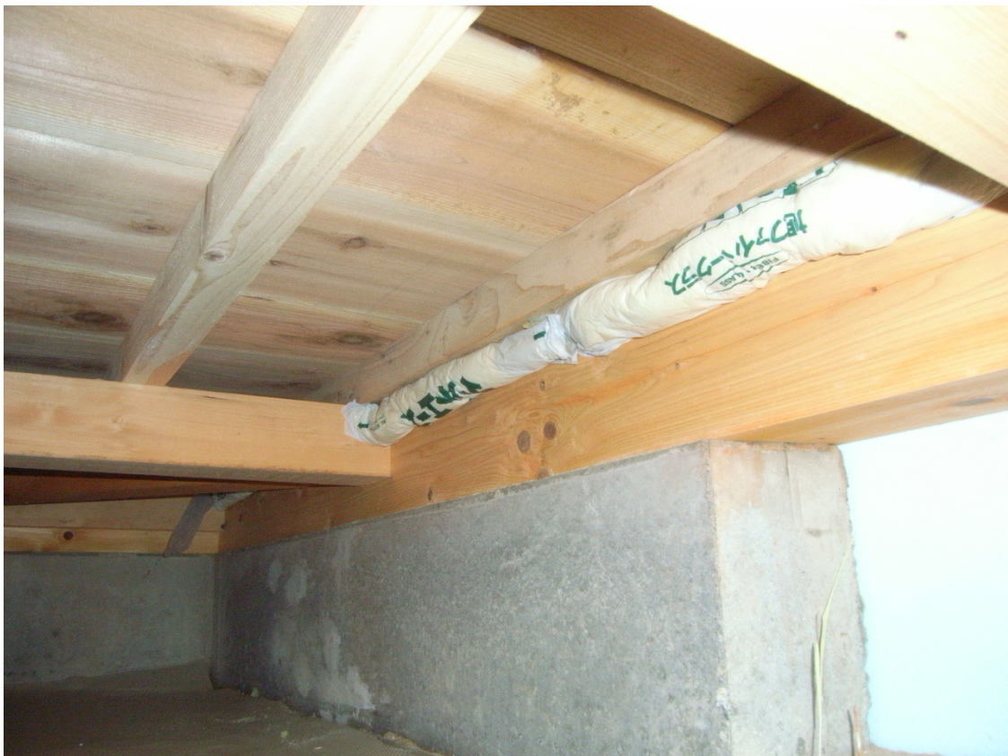
図2.2.3 床下の気流止め
