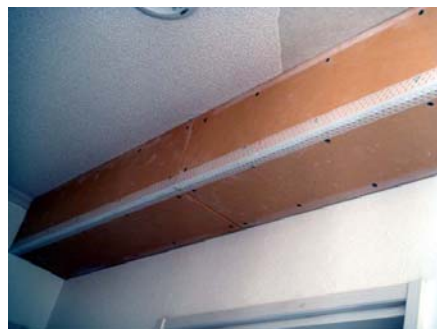
写真2.4.4 ダクト隠し用下がり天井
