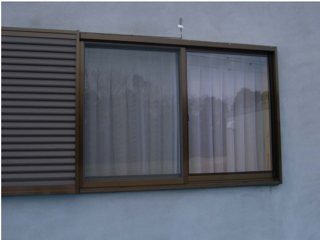
図2.2.10 施工後のサッシ
