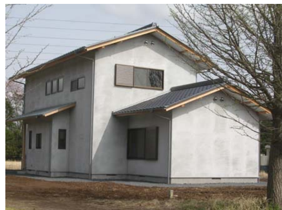
図2.1.4 外観写真 (北・西面)
