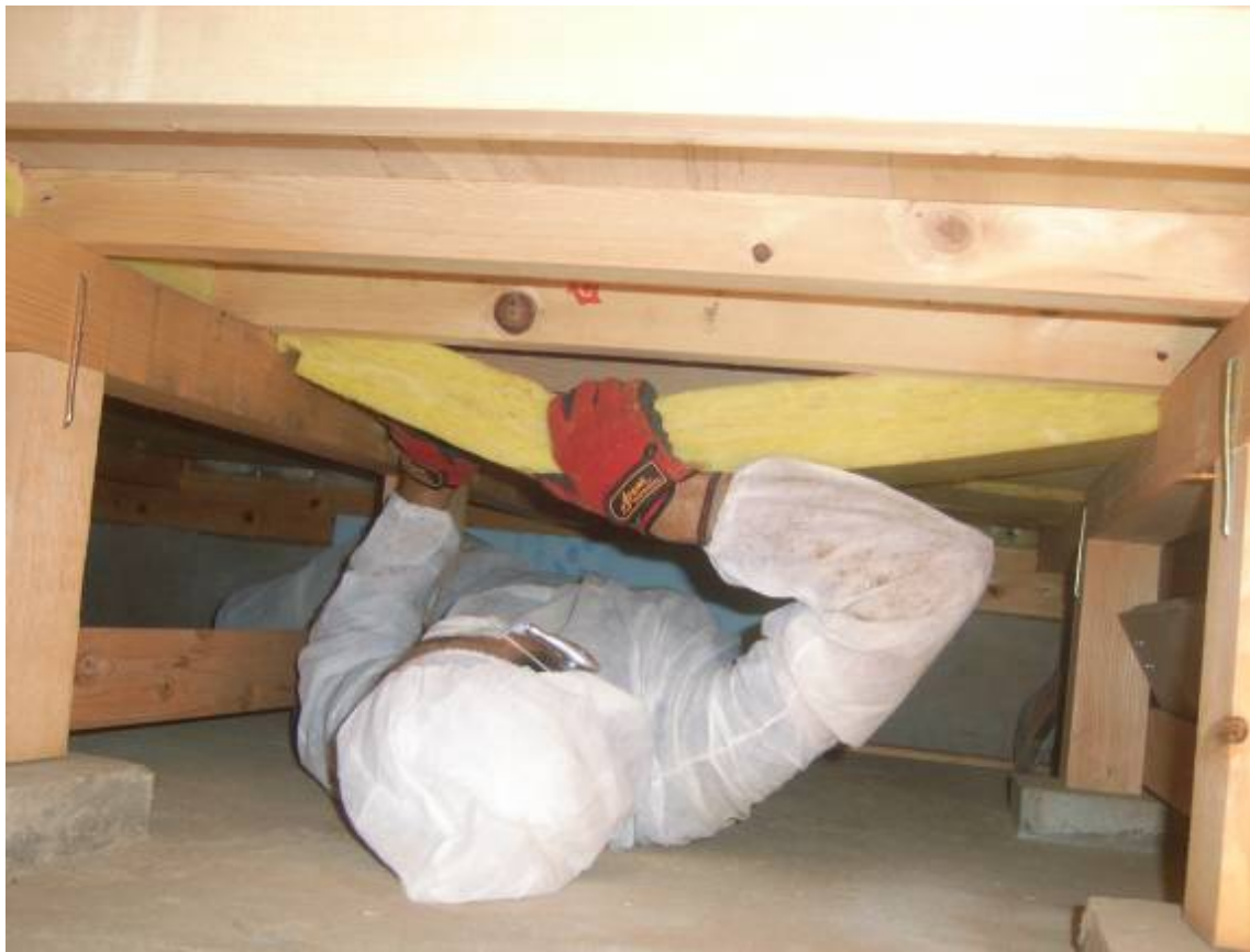
図2.2.7 根太間への断熱材挿入
