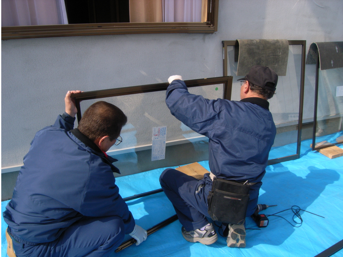
図2.2.9 サッシ障子の分解
