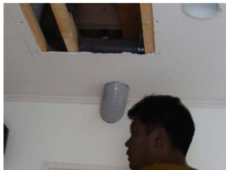
写真2.4.2 ダクト外梁下通過部処理
