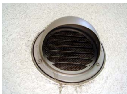
写真2.4.5 防虫網付外部フード
