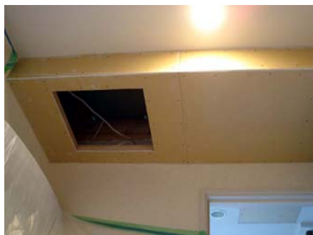
写真2.4.3 本体埋設用下がり天井
