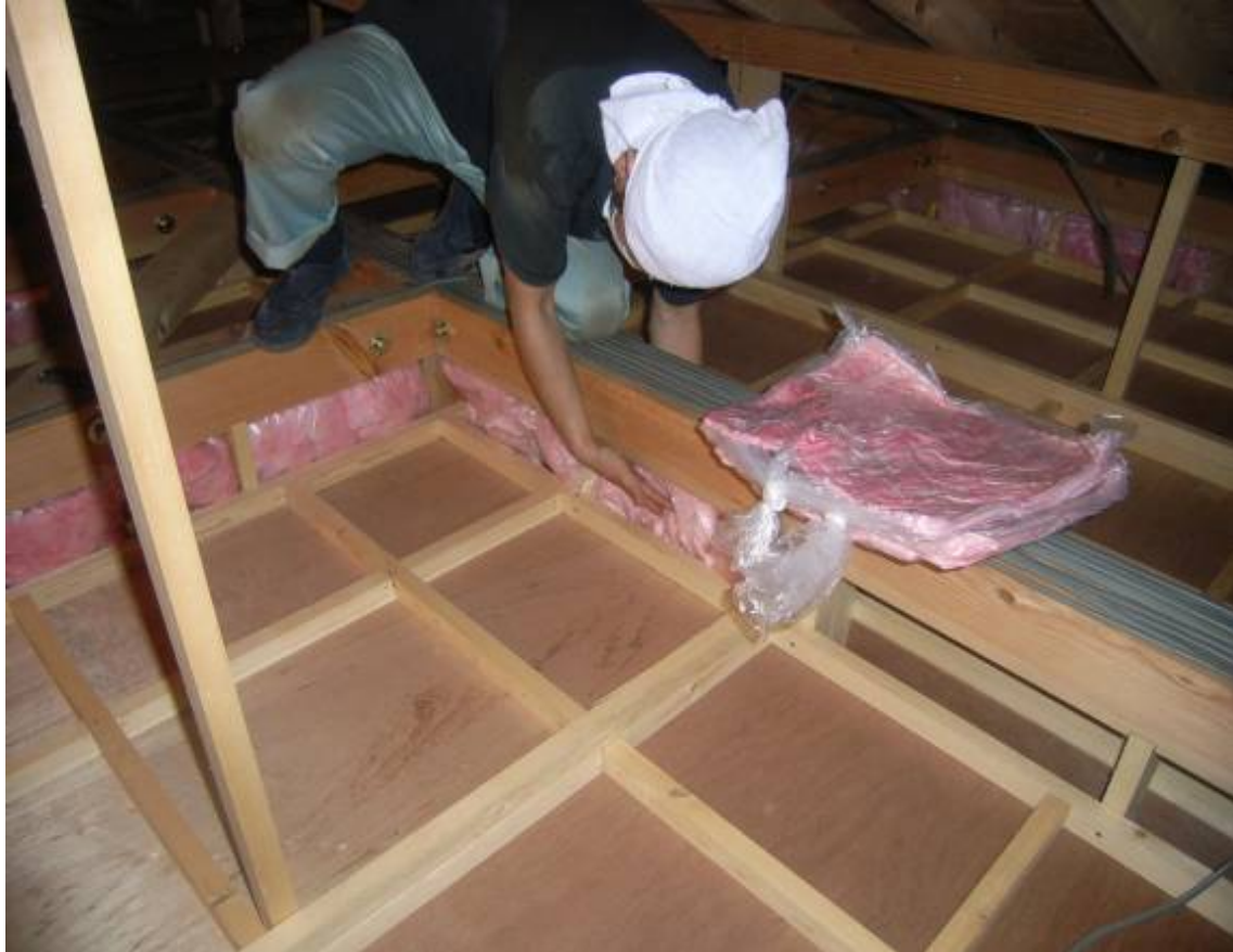
図2.2.6 小屋裏の気流止め
