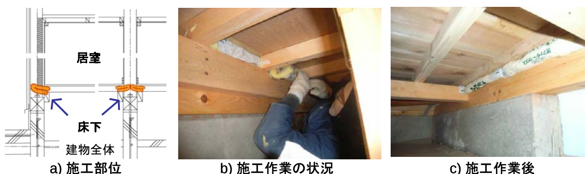
図1.2.1 気流止め施工実験の状況
