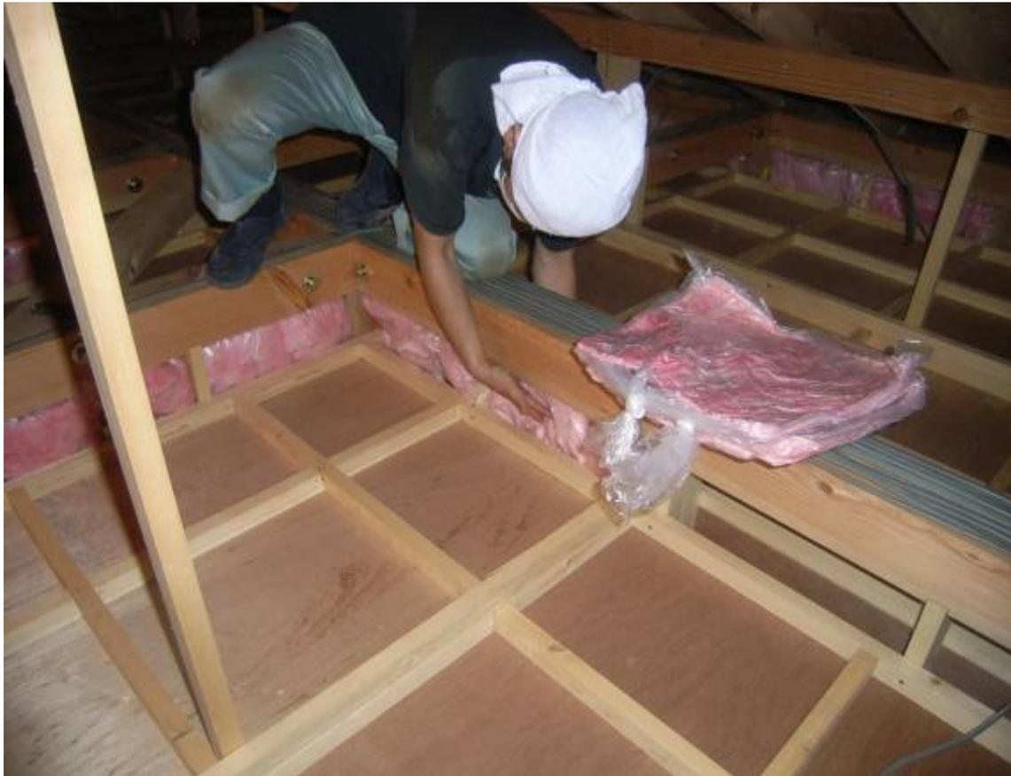
図2.2.6 小屋裏の気流止め
