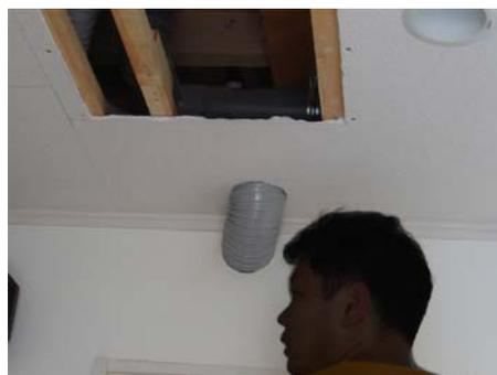
写真2.4.2 ダクト外梁下通過部処理
