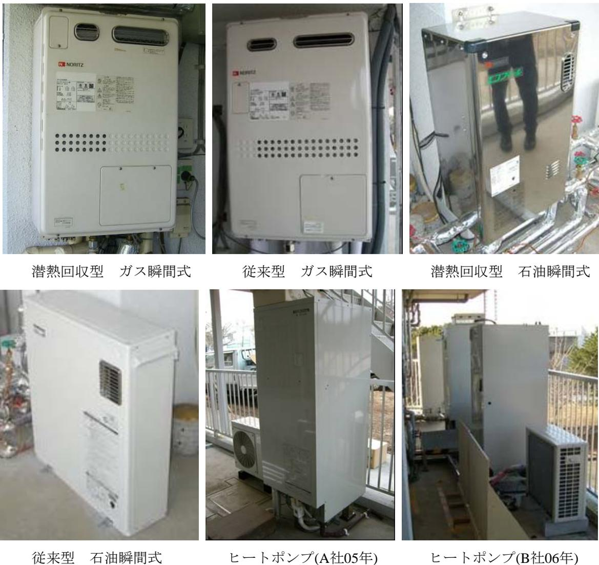
図4.3.1 試験対象給湯機（熱源）
