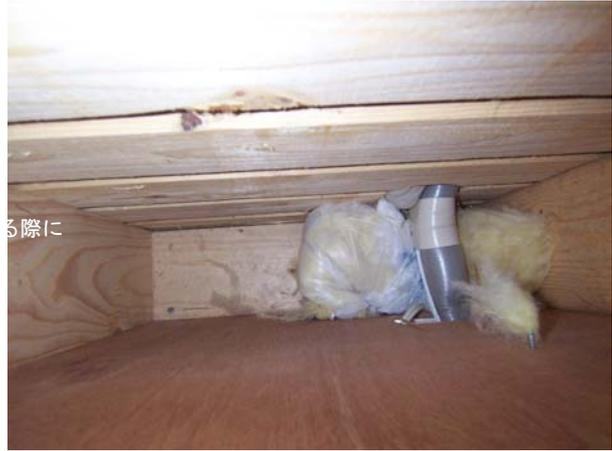
図3.1.3 エアコン設置工事の際に生じた断熱欠損の例
