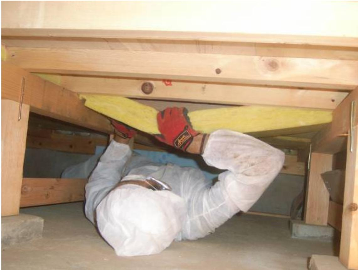
図2.2.7 根太間への断熱材挿入
