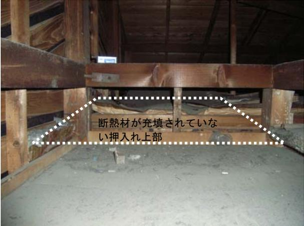
図3.1.4 押入れ上部の断熱欠損の例
