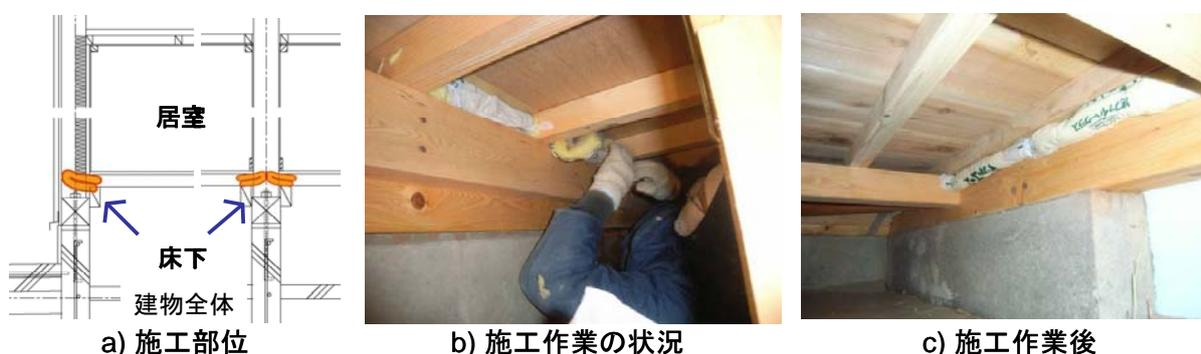
図1.2.1 気流止め施工実験の状況
