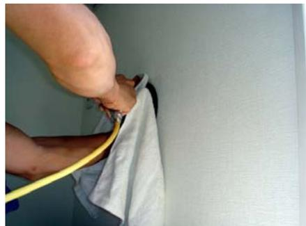
写真2.4.6 圧縮空気による掃除状況
