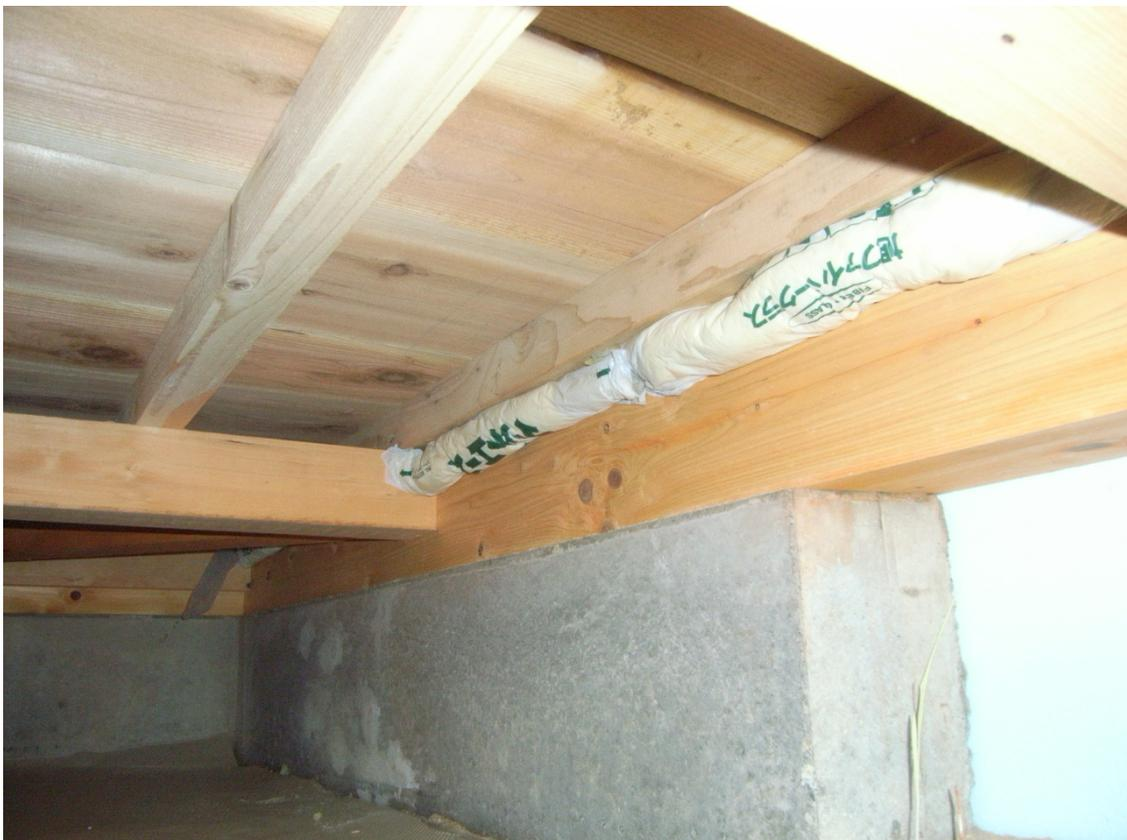
図2.2.3 床下の気流止め
