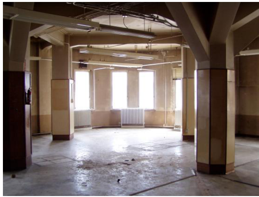
内部現況写真（コーナー部）
