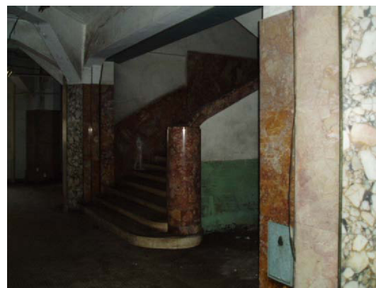
階段室の内部仕上げ
