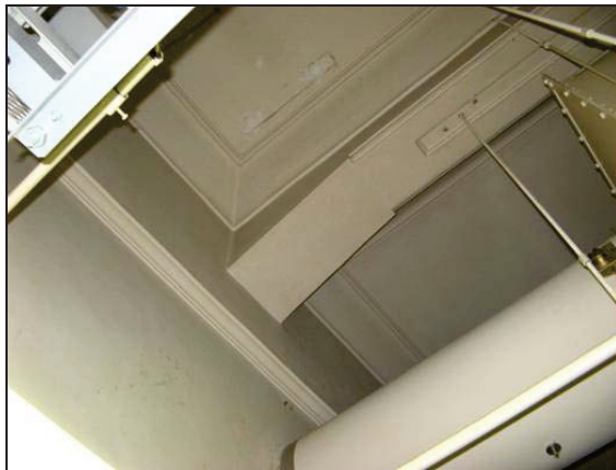
機械室 梁型・廻縁
