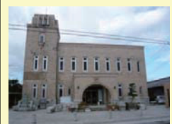
ケース2 郷土資料館 （旧市役所庁舎）
