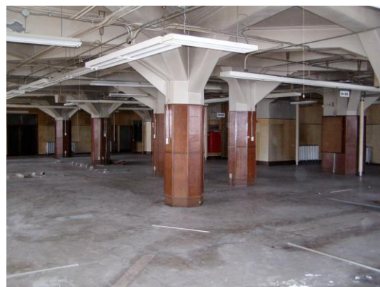
内部現況写真（全景）
