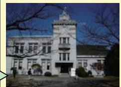
ケース1 地方気象台庁舎
