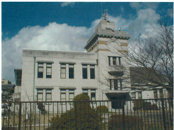
図 3-3-1 庁舎南側全景
