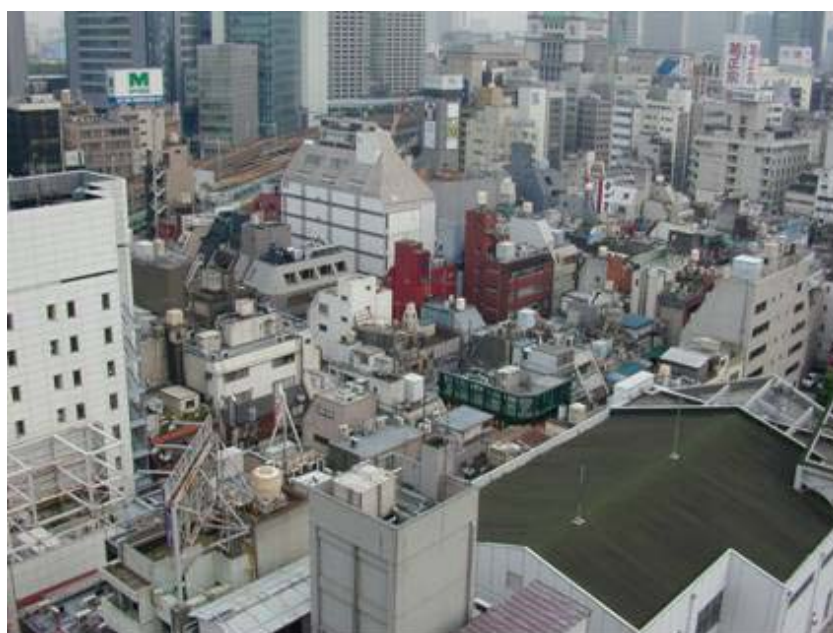
図 5-3-2 対象地区の状況
