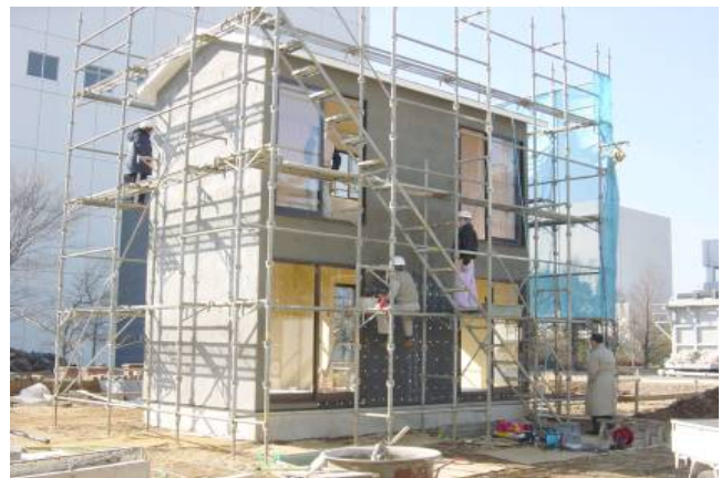
写真-2 2階建て試験棟の施工・解体実験
