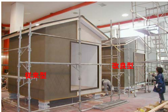
写真-1 モデル試験棟の施工解体実験
