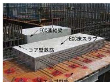
図 3.38 ECC 連結梁の施工状況
