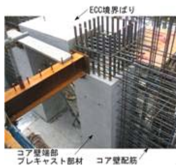
図 3.39 ECC 連結梁の設置状況
