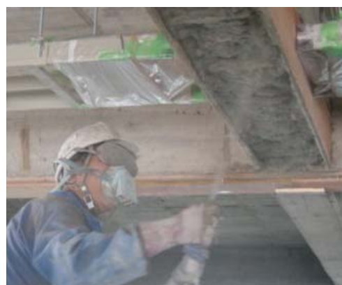
写真 3.3 吹き付け施工の様子
