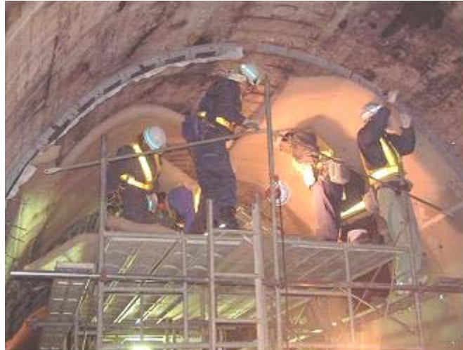
図 3.9 トンネル覆工コンクリートの補修・補強に用いる PVA 繊維マット
