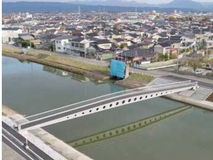
図 3.10 繊維補強 RPC を用いた PC 橋梁（酒田みらい橋）
