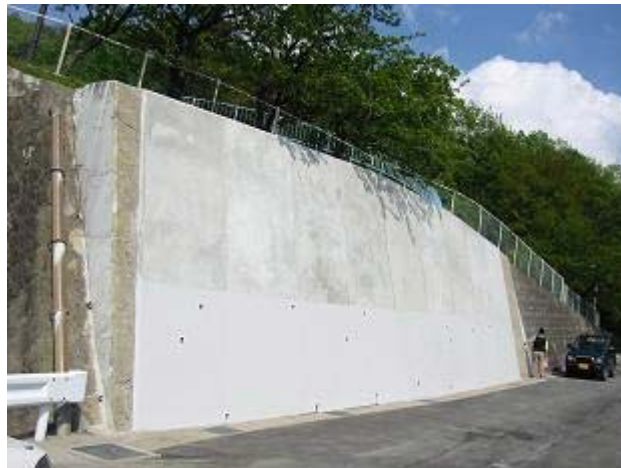
図 3.5 表面保護工として ECC を吹き付けた重力式コンクリート擁壁
